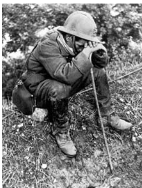
Soldat français accablé par la défaite de 40 © Établissement de communication et de production audiovisuelle de la Défense
