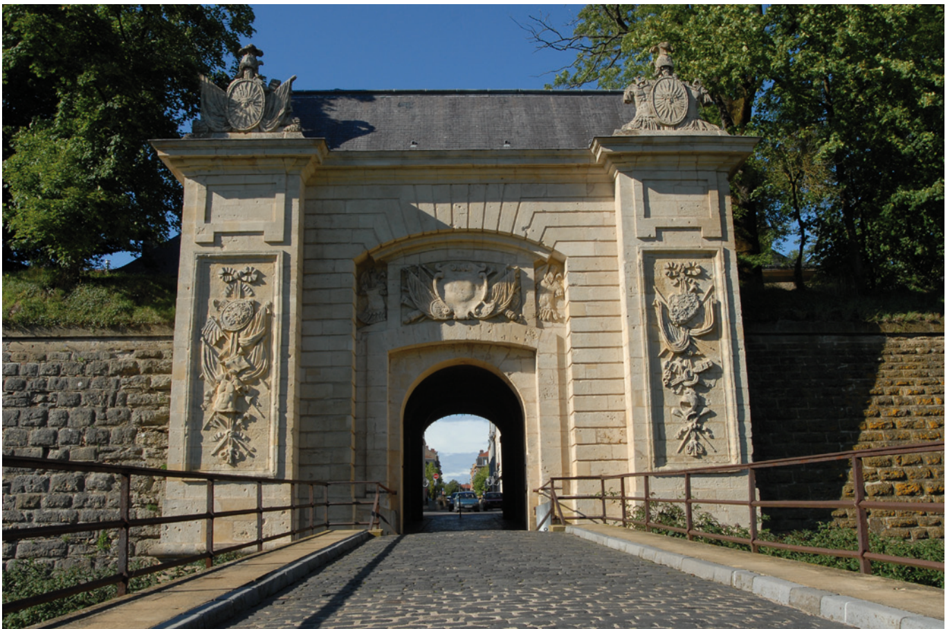
▼ Document 3 : Porte de France de la place forte de Longwy
